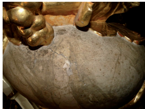
Risse in der Oberfläche einer Säule
