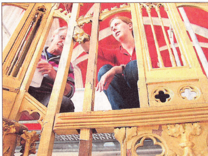
Restauratorin Fuchs arbeitet in acht Metern Höhe.
